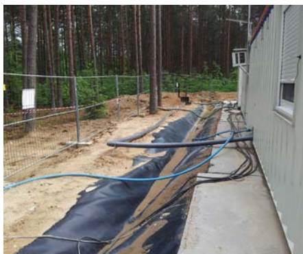
5 pav. Gręžvietės pakraščių sutvarkymas. Aplinkui aikštelę suformuotas ir polietileno plėvele išklotas griovys surenka nuotekas
